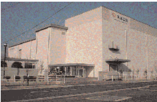
最新鋭の基山第二工場
