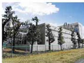
排水処理設備の更新（石岡工場）
