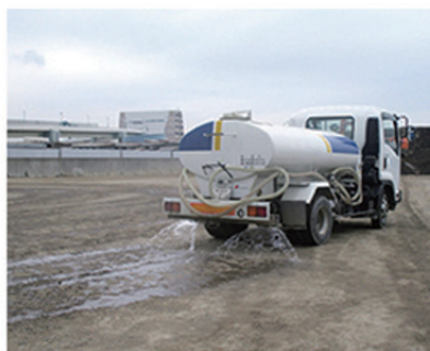
浮島地区埋立作業地での散水の様子
