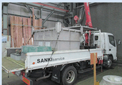
高濃度PCB高圧コンデンサの搬出作業
