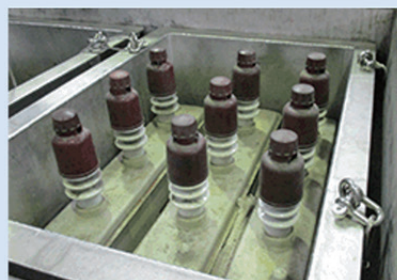
高濃度PCB高圧コンデンサの搬出作業
