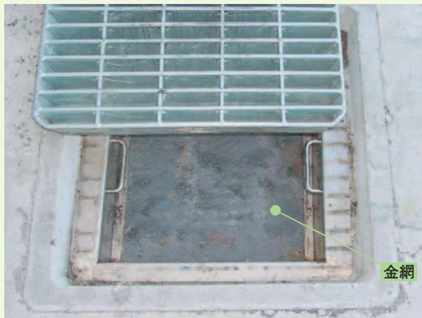
ペレット流出防止雨水溝金網(大阪工場)
